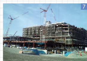
▲平成19年、江南厚生病院新築工事の様子(愛北病院・昭和病院の統合)
