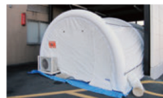
▲陰圧テント(稲沢厚生病院)
